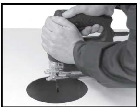
Trin 4. Skær udsugningshul i maskinkabinettet.
